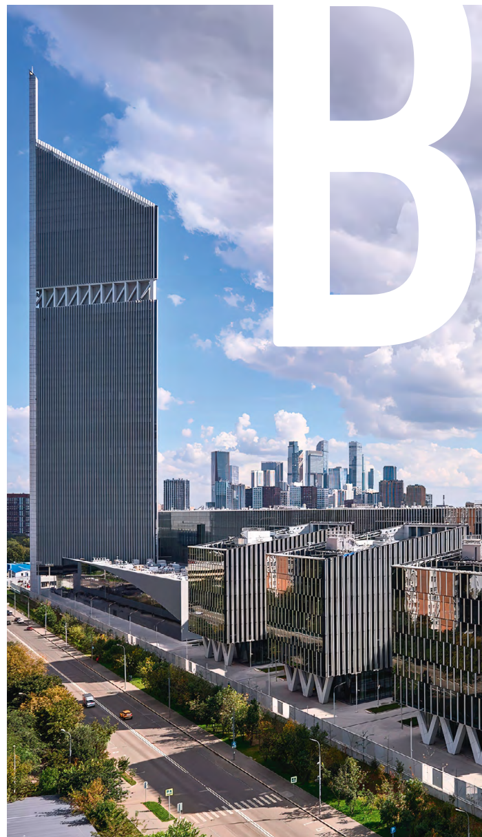
Фото: пресс-служба Градостроительно-земельной администрации Москвы
