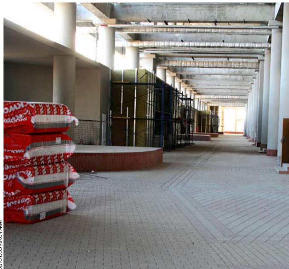
Подтрибунное помещение 2-го яруса
