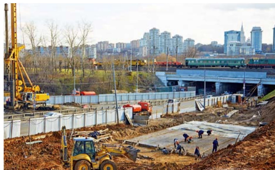
Строительство обьездной дороги. Второй пусковой комплекс. Пересечение улиц Минской и Старовольницкой
