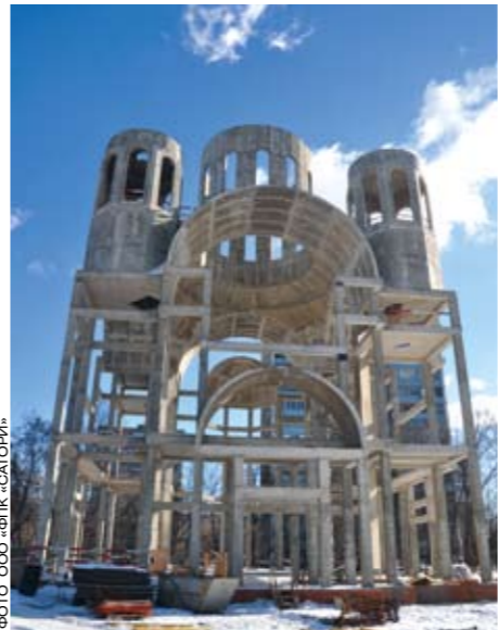
Строительство храма Введения во храм Пресвятой Богородицы в Вешняках на ул. Кетчерской, вл. 2
