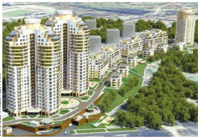
Жилой комплекс на ул. Юннатова, г. Екатеринбург
