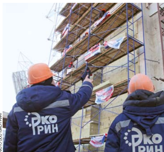
Работы ведет ООО «ЭКО-ГРИН»
