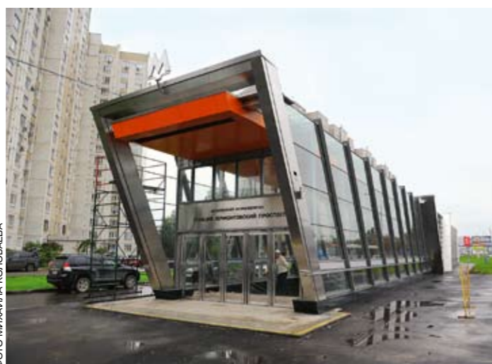
Строительство выхода из станции м. «Лермонтовский проспект», г. Москва
