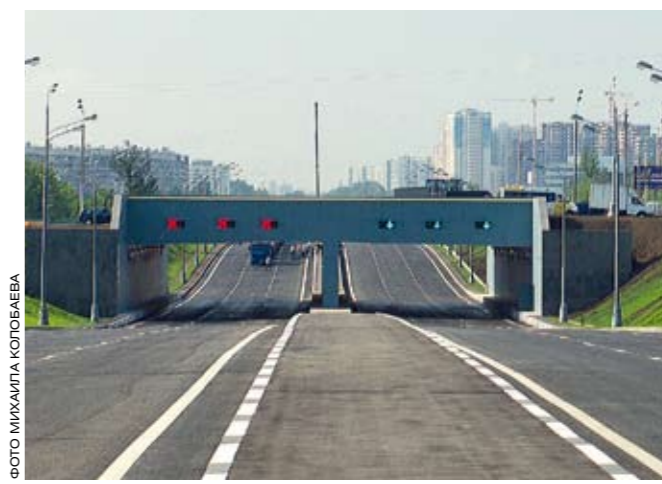
Реконструкция Варшавского шоссе от МКАД до Садового кольца, г. Москва
