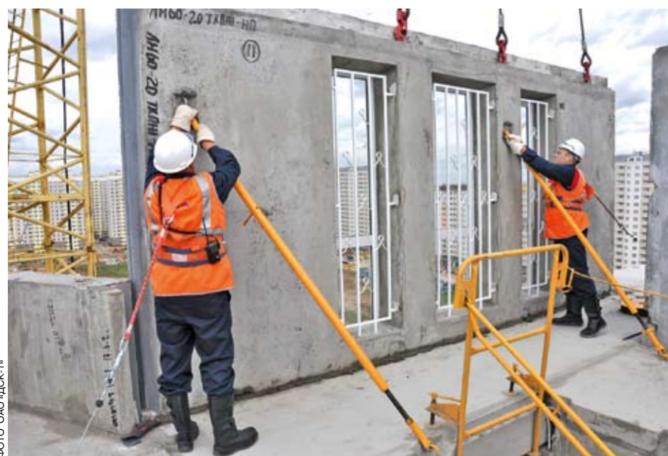
Монтаж оконной конструкции на высоте 14-го этажа
