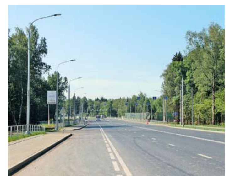
Автодорога от Боровского до Киевского шоссе
