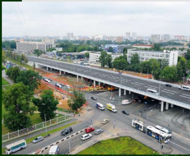
Реконструкция Ярославского шоссе
