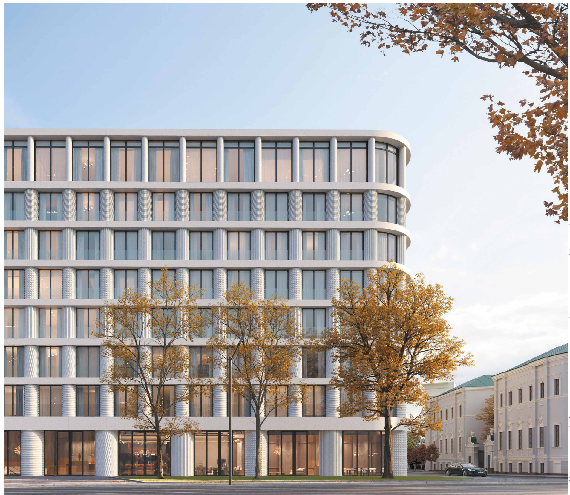
Реконструкция. Эксплуатационное ООО «СЗ ТРЕТИЙ РИМ», ОГРН 118774637724, 125009, Москва, ул. Б. Никитская, д.16, этаж 3, ком. 6. Проектная декларация на сайте nskidom6.ru
